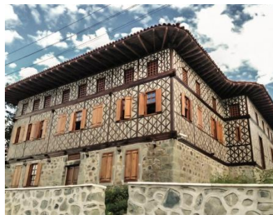
Şekil 7: Geleneksel muska dolma sistemi uygulaması örneği. (Güler ve Bilge, 2011)
