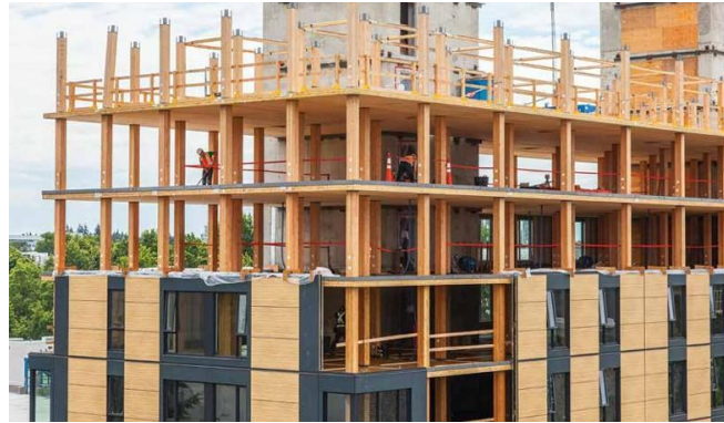
Şekil 17: Brock Commons Tallwood House binası şantiye aşaması. (Naturally:wood t.y.)
