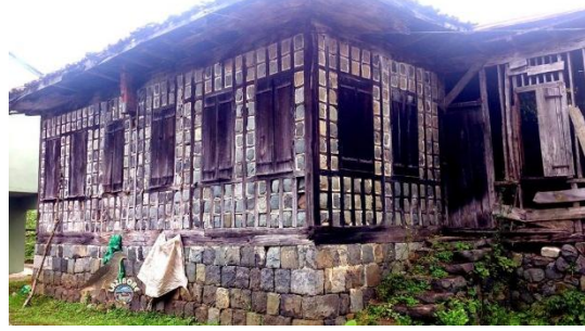
Şekil 6: Geleneksel göz dolma sistemi uygulaması örneği. (Algül, 2011)
