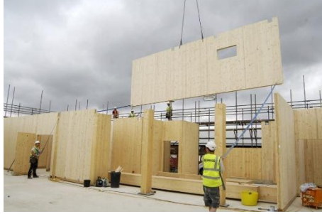
Şekil 12: CLT panel sistem montaj örneği. (Gibson, 2017)
