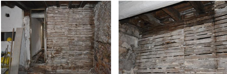
Şekil 5: Bağdadi duvar çıtalama örneği. (Öznur, 2011)
