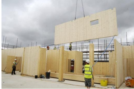
Şekil 12: CLT panel sistem montaj örneği. (Gibson, 2017)
