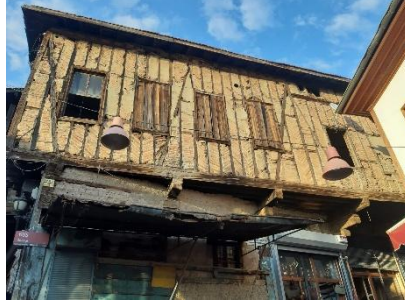
Şekil 4: Hımış tekniği kullanılarak yapılmış bir duvar örneği. (Yazar arşivi, 2022)
