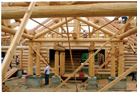
Şekil 10: Endüstriyel ahşap yığma sistem uygulaması örneği. (Johns, 2023)
